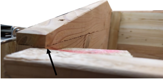
Ajuster chaque façade au niveau de la planche indiquée et visser la planche du bas
